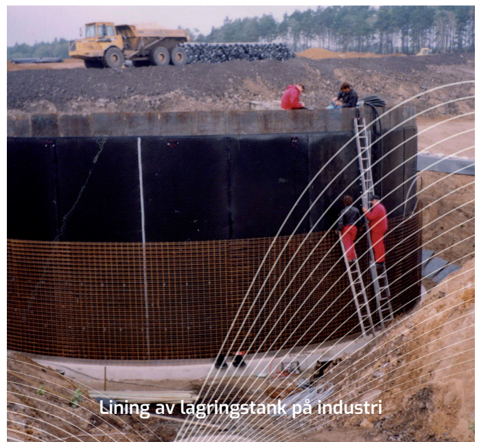
Svetsning av betongskyddsliner
